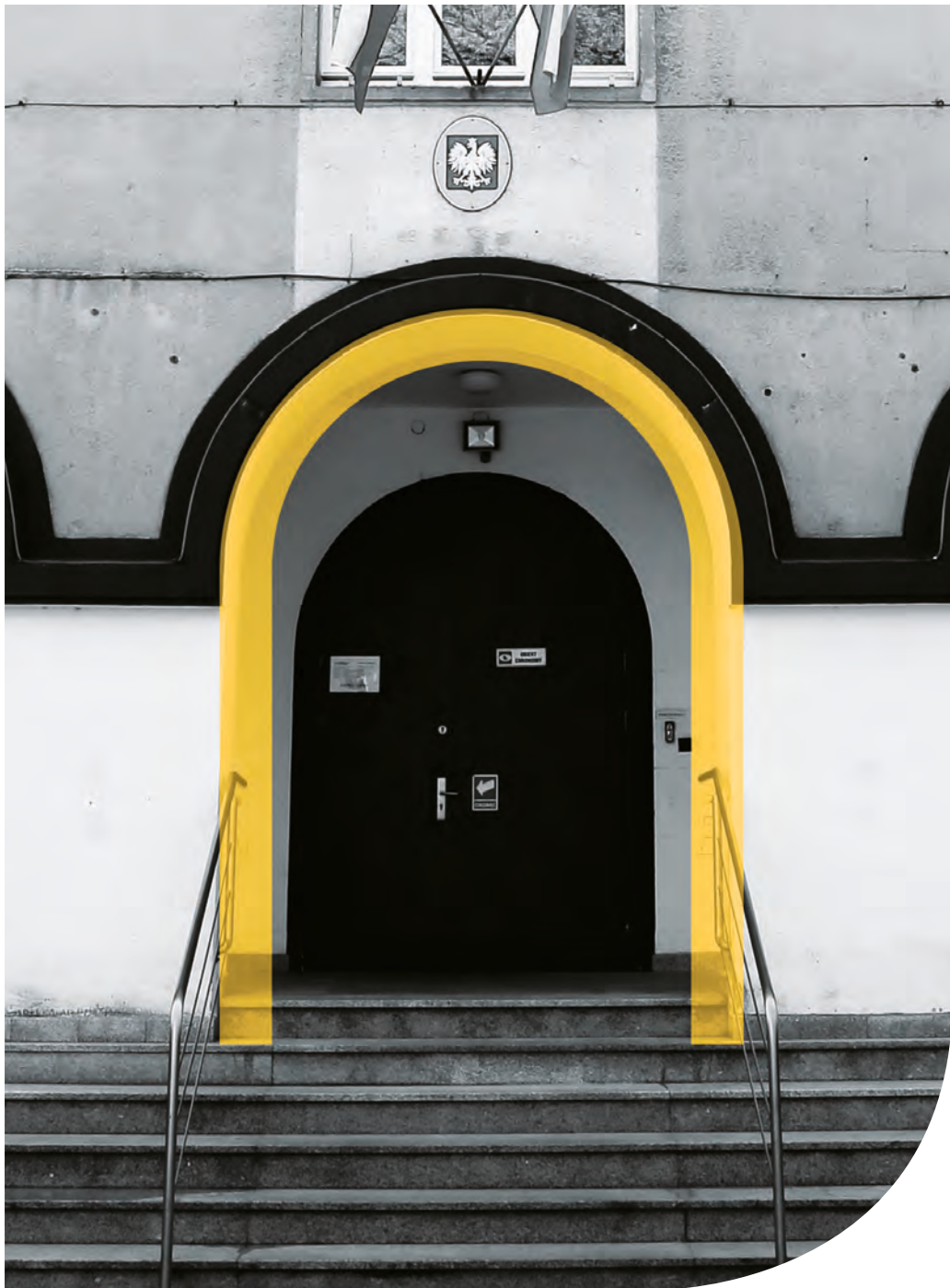
Urząd Miejski ul. Kolejowa 15
